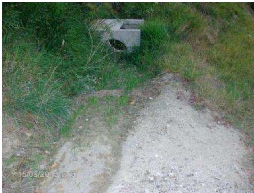
Tombini in cls disfatti da sostituire
