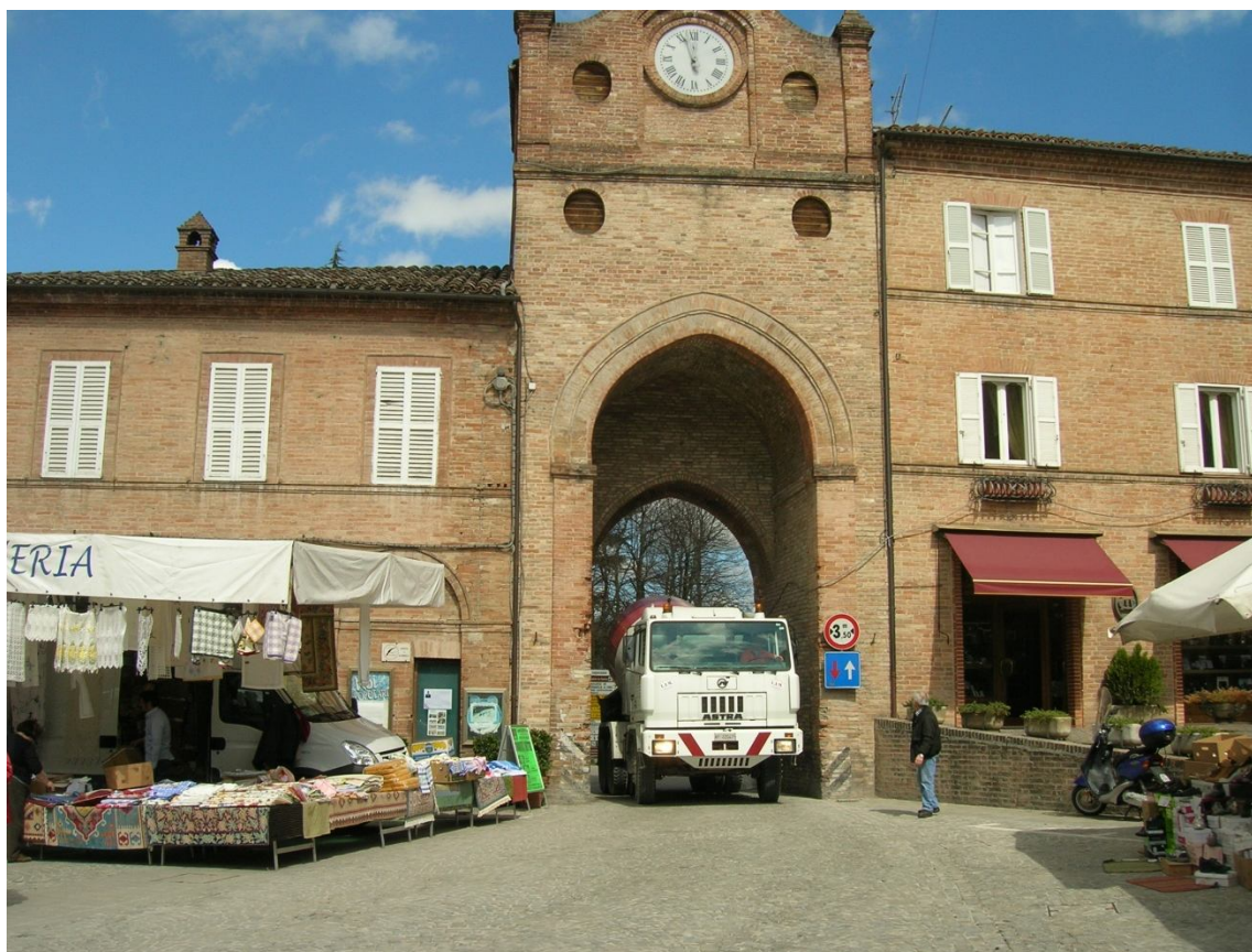
Arco tra Piazza Risorgimento e Piazza Garibaldi attualmente utilizzato per il traffico veicolare di attraversamento del centro abitato di Amandola.
