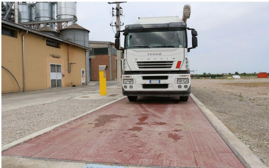
La struttura nel suo complesso è composta da una **platea di fondazione in cemento armato** ed una **struttura metallica portante a travi longitudinali**, appositamente dimensionata per mantenere inalterate le caratteristiche di resistenza e precisione dell'impianto di pesatura a lungo nel tempo. Il trattamento di
