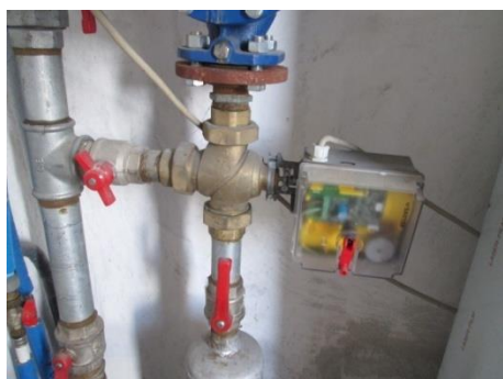
Particolare valvola a 3 vie e quadro elettrico
