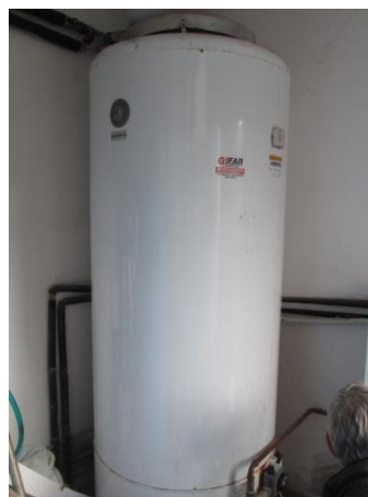
Particolare caldaia murale e scaldacqua a gas
