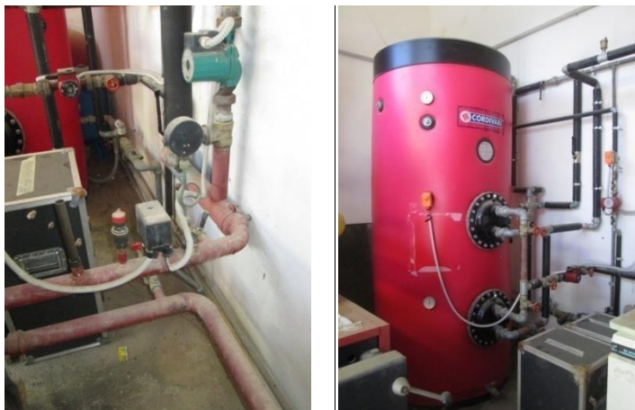
Particolare elettropompa e bollitore
