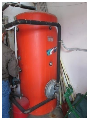
Particolare circolatori e bollitore ad accumulo
