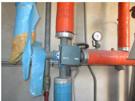
Particolare valvola a 3 vie e bollitore
