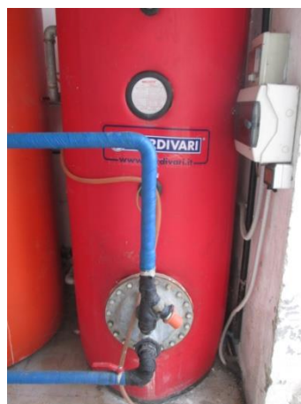
Particolare elettropompa e valvola a 3 vie e bollitore
