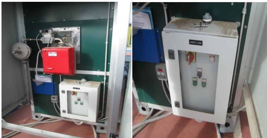
Particolare bruciatore e quadro elettrico
