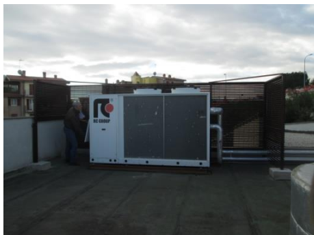
Particolare refrigeratore d'acqua e unità trattamento aria
