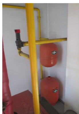
Particolare gruppo termico e dispositivi INAIL- Valvola a tre vie
