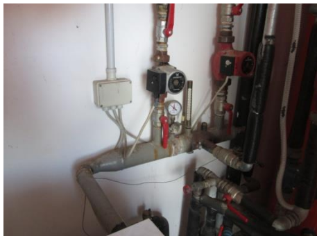
Particolare circolatori e bollitore ad accumulo
