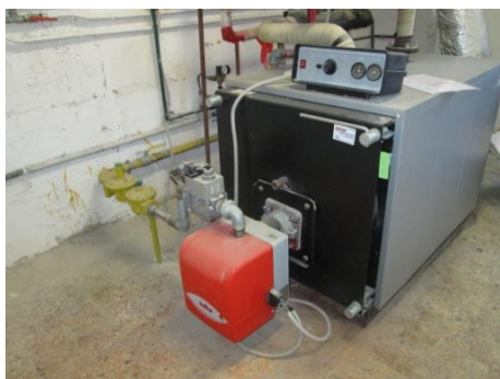
Particolare gruppo termico ed elettropompa
