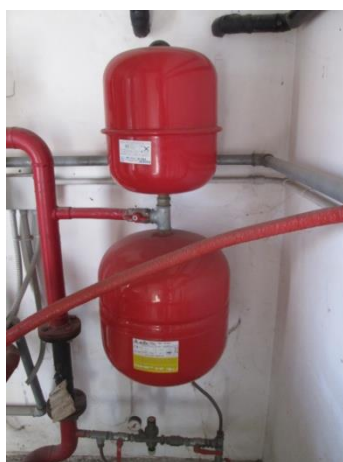
Particolare dispositivi INAIL e scaldacqua a gas
