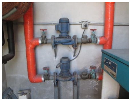
Particolare gruppo termico e dispositivi INAIL
