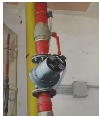
Vista centrale di cogenerazione e particolare circolatore
