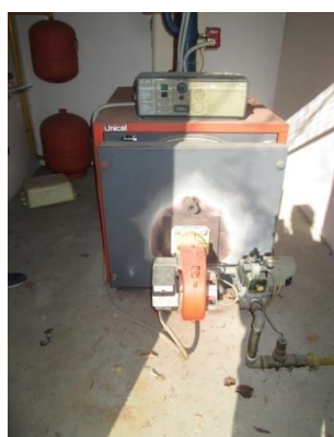
Particolare gruppo termico e dispositivi INAIL- Valvola a tre vie
