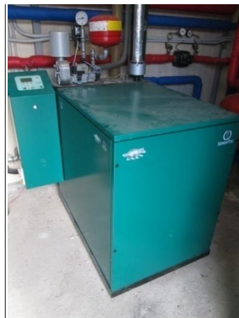
Vista centrale di cogenerazione e particolare microcogeneratore
