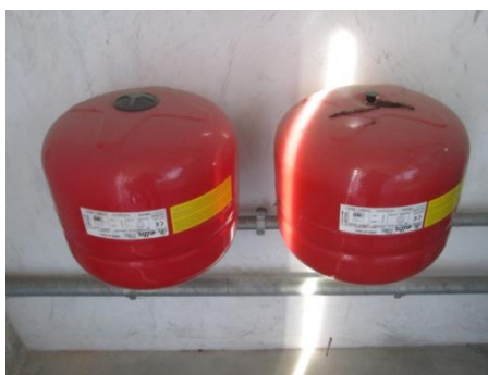
Particolare elettropompa e vasi di espansione
