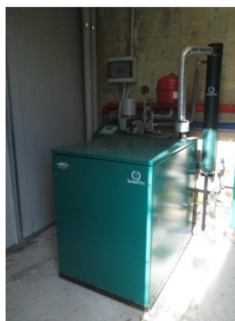
Vista centrale di cogenerazione e particolare microcogeneratore
