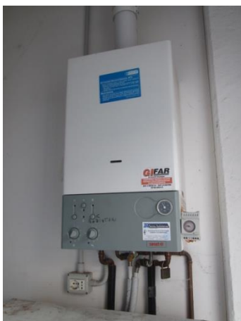
Particolare caldaia murale e scaldacqua a gas
