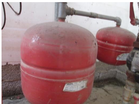
Particolare vasi di espansione e quadro elettrico
