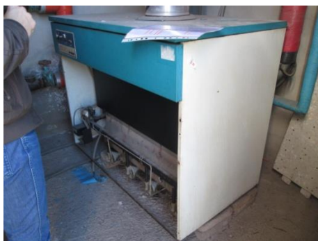
Particolare gruppo termico e dispositivi INAIL
