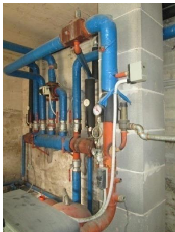
Particolare collettore di distribuzione
