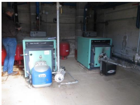
Particolare gruppi termici ed elettropompa
