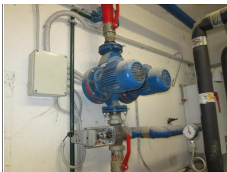
Particolare gruppo termico ed elettropompa
