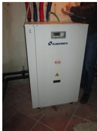
Vista fabbricato e pompa di calore geotermica
