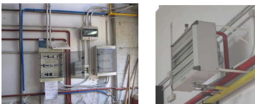
Particolare quadro elettrico e aerotermo
