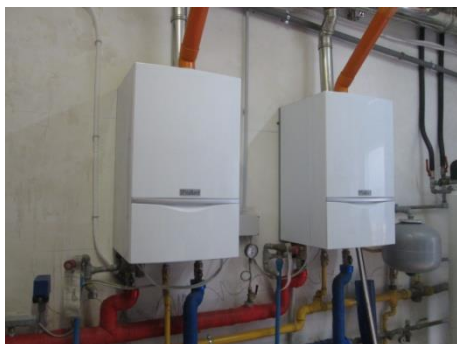
Particolare modulo termico e scaldacqua a gas
