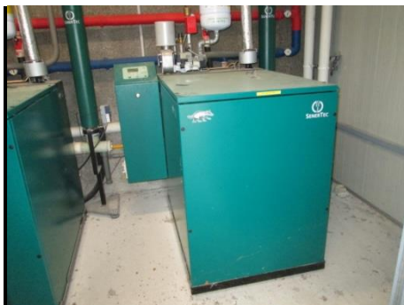
Vista centrale di cogenerazione e particolare microgeneratore
