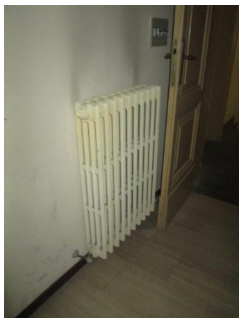
Particolare caldaia murale e radiatore in ghisa ed a gas
