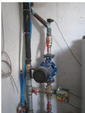
Particolare elettropompa e vasi di espansione
