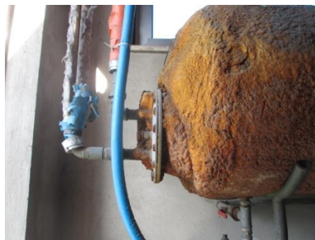
Particolare valvola a 3 vie e bollitore
