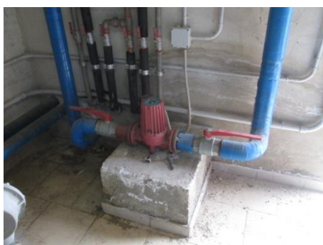
Particolare elettropompa e bollitore
