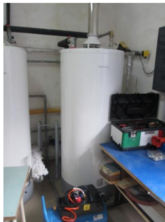
Particolare modulo termico e scaldacqua a gas
