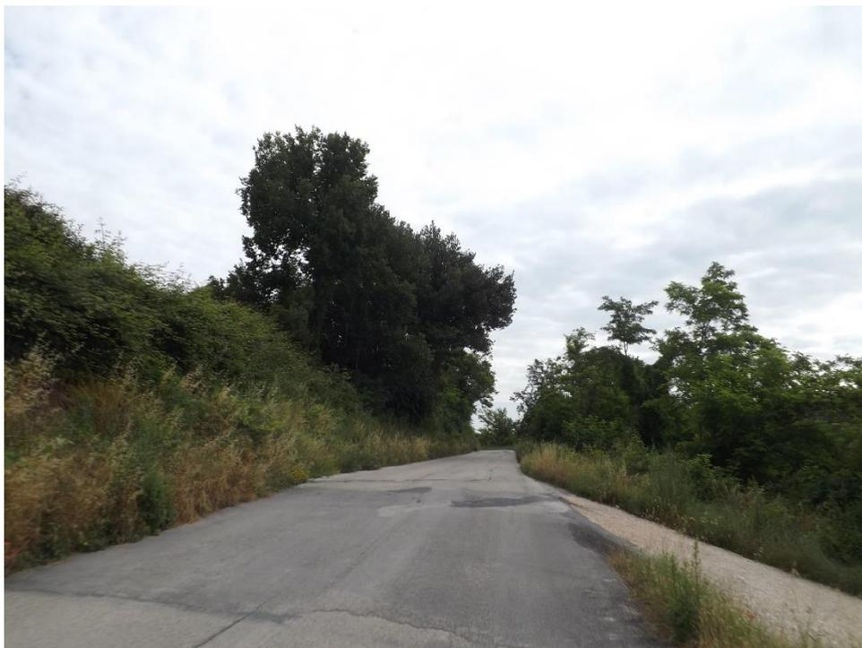
**Foto 1. S.P. 61 - Km 3+370 circa - Avvallamenti della pavimentazione stradale con fessurazione trasversale.**
