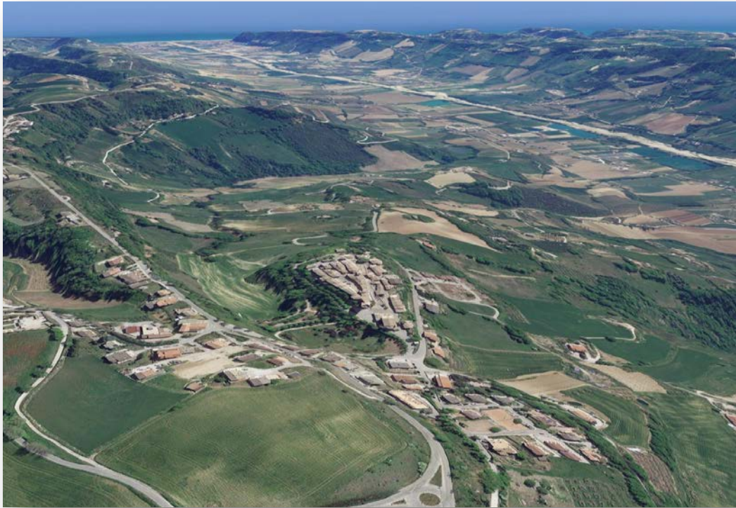
Centro abitato di Moresco
