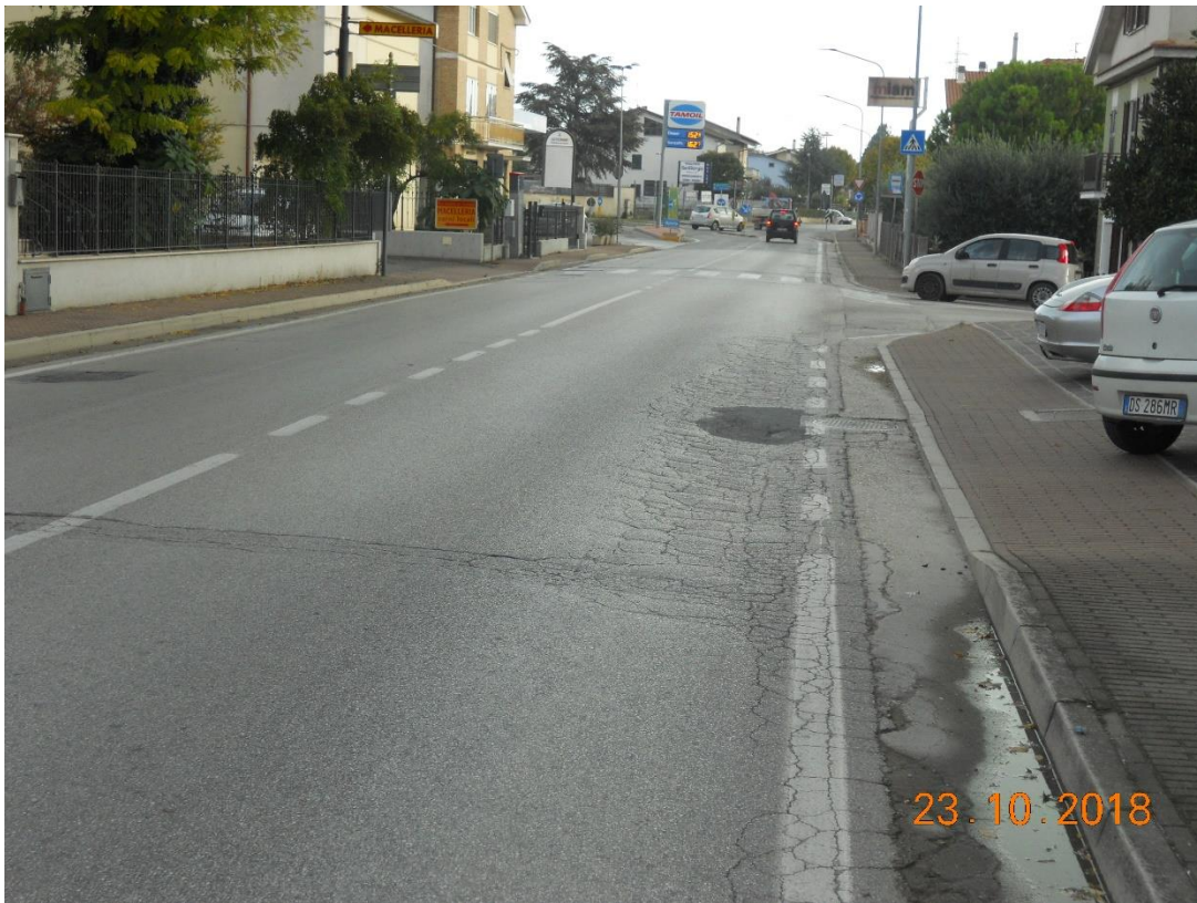
Foto 1. Avvallamenti del piano viario con fessurazione a ragnatela delle fasce laterali della pavimentazione stradale.
