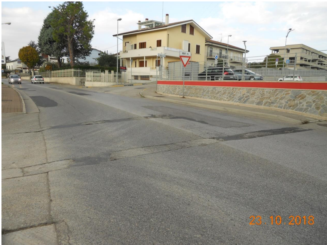
Foto 3. Avvallamenti del piano viario con usura diffusa del manto stradale.
