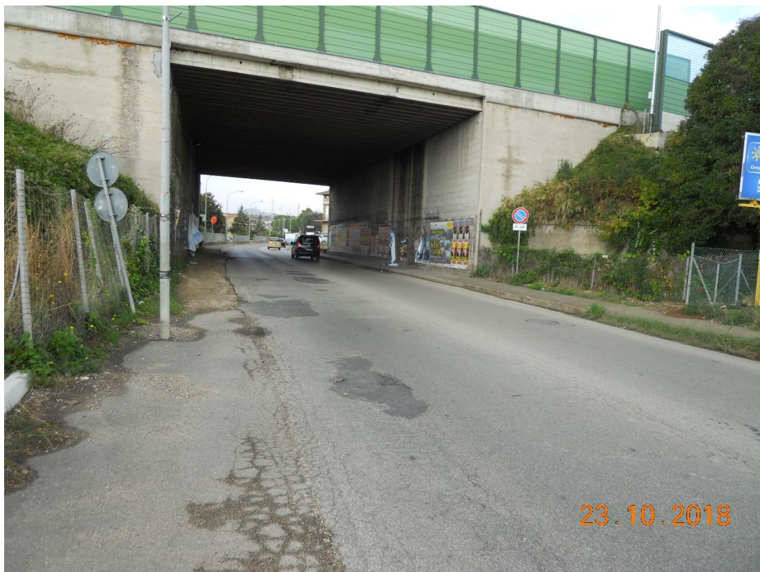
Foto 4. Avvallamenti del piano viario con fessurazione a ragnatela delle fasce laterali della pavimentazione stradale ed usura dello strato superficiale.
