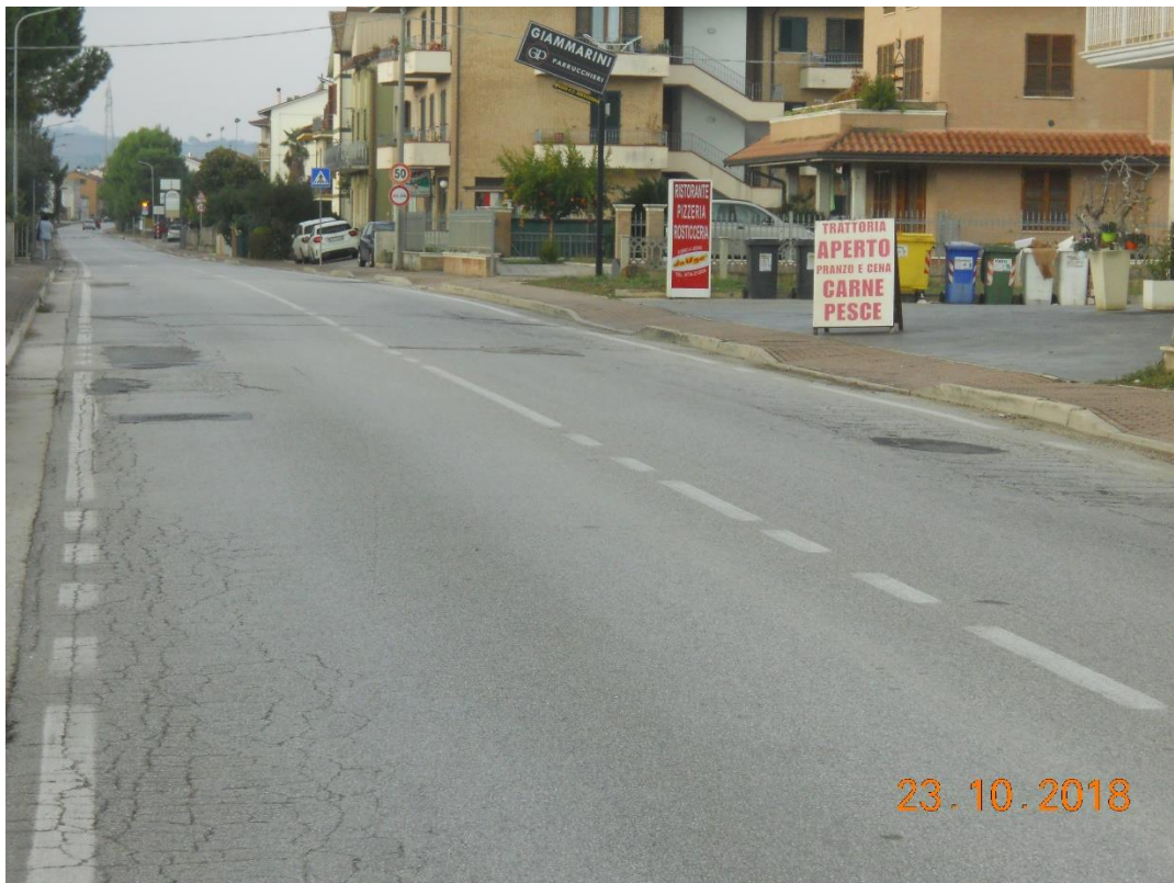
Foto 2. Avvallamenti del piano viario con fessurazione a ragnatela delle fasce laterali della pavimentazione stradale.
