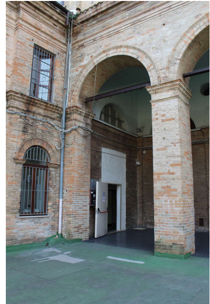
Ingresso lato est del cortile interno
