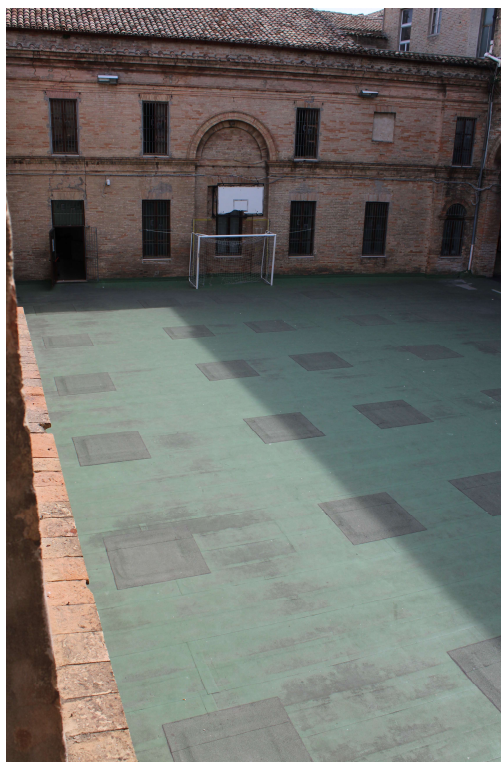
Vista area da occupare su cortile interno Convitto per allestimento ponteggi
