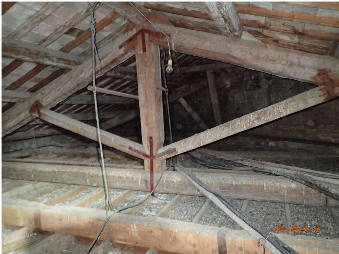
Struttura di copertura oggetto di rifacimento (sottotetto)
