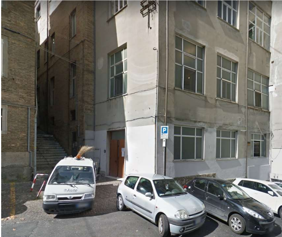
Ingresso secondario da Via Montani
