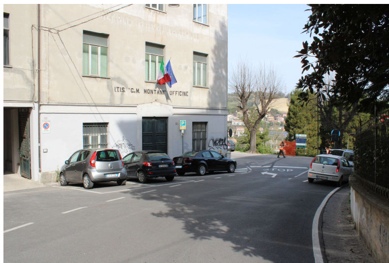
Viabilità su Via Montani
