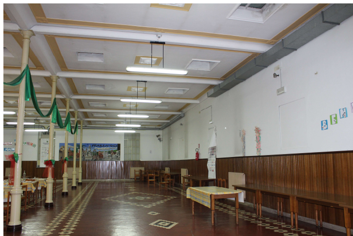
Porzione di refettorio da puntellare ed ineterdire
