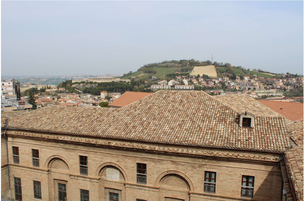
Struttura di copertura oggetto di rifacimento
