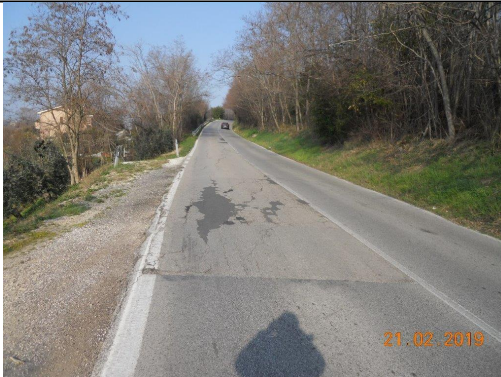
Foto 1- Avvallamenti del piano viario con fessurazioni longitudinali e trasversali della pavimentazione stradale ed usura dello strato superficiale.
