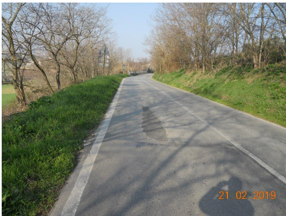
Foto 4- Avvallamenti del piano viario con fessurazioni longitudinali e trasversali della pavimentazione stradale ed usura dello strato superficiale.
