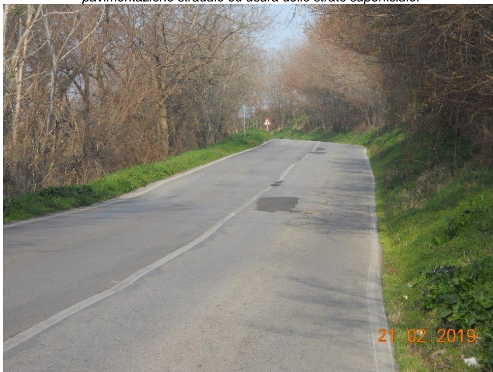
Foto 2- Avvallamenti del piano viario con fessurazioni longitudinali e trasversali della pavimentazione stradale ed usura dello strato superficiale.
