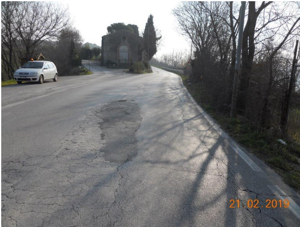
Foto 5- Avvallamenti del piano viario con fessurazioni longitudinali e trasversali della pavimentazione stradale ed usura dello strato superficiale.
