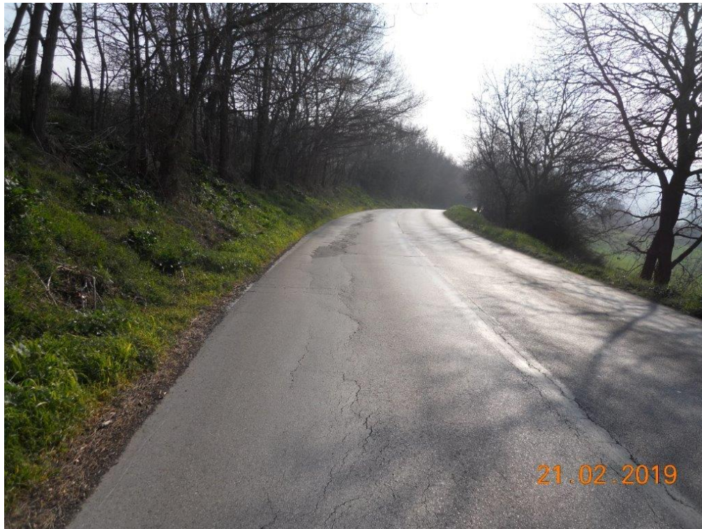
Foto 3- Avvallamenti del piano viario con fessurazioni longitudinali e trasversali della pavimentazione stradale ed usura dello strato superficiale.
