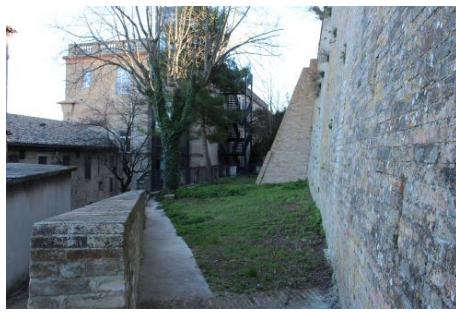
Area di installazione della gru e alberi interferenti
