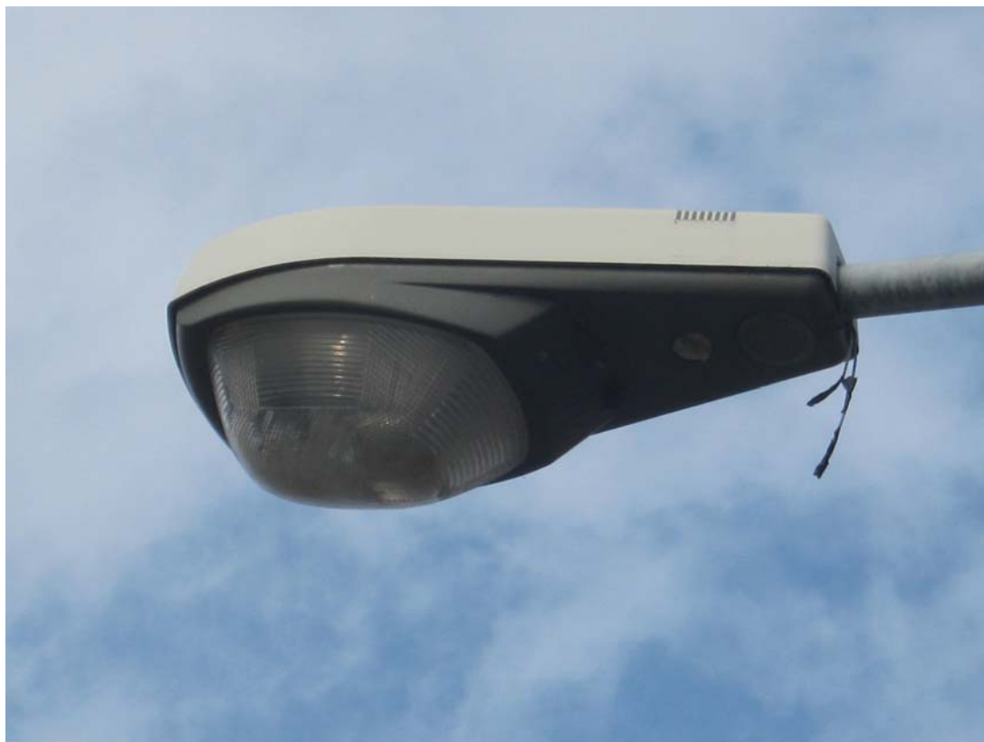
Figura 2: Esempio di corpo illuminante stradale tipo ASP, ma non a norma con la legge regionale.
