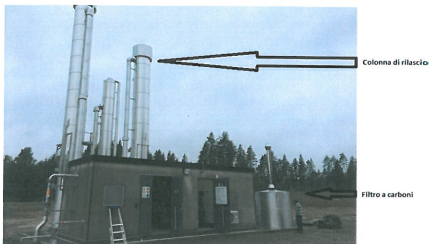
Impianto Malmberg Compact GRBAS con sistema di filtro a carboni
