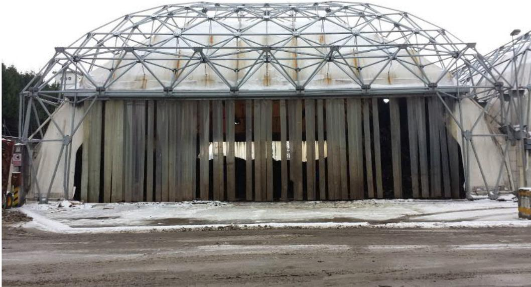
Figura 10: Tensostruttura utilizzata per la biossidazione della FORSU
