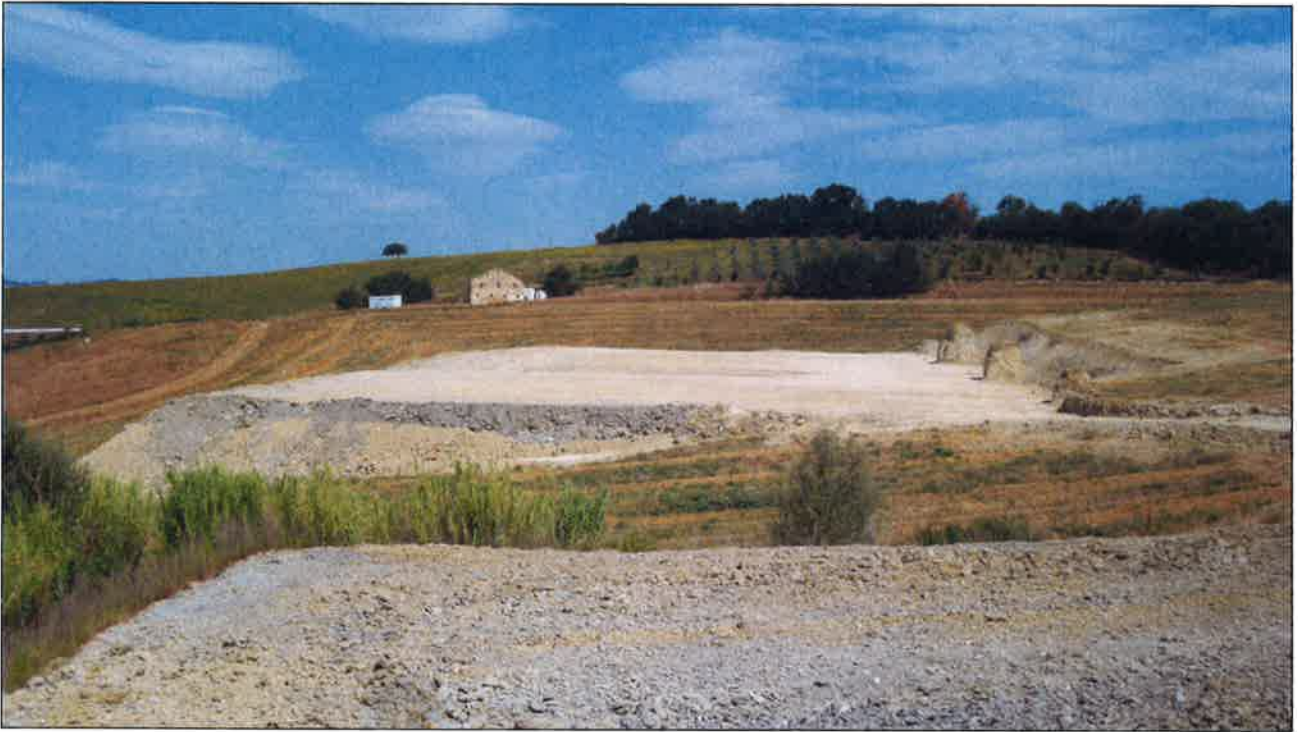
Foto1: Realizzazione piazzale struttura 4
