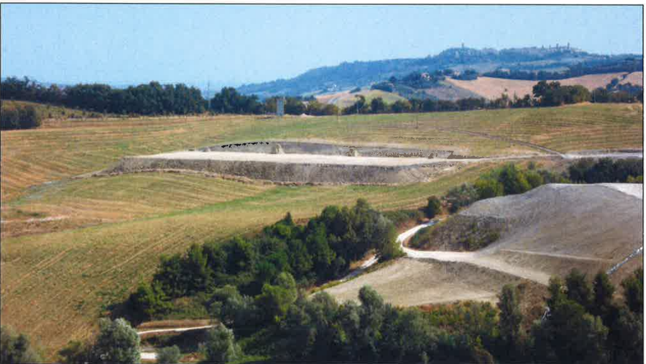
Foto2: Vista panoramica da W dei lavori di realizzazione dell'impianto di compostaggio
