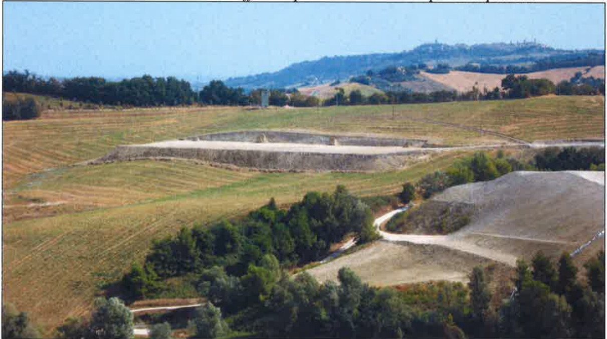
Foto n. 6 – Lavori di movimento terra effettuati per la realizzazione di parte del piazzale struttura 4
