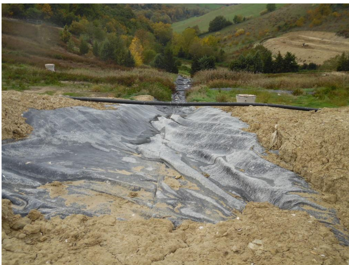
Figura 13: Foto 4-Canaletta superficiale principale per raccolta acque meteoriche
