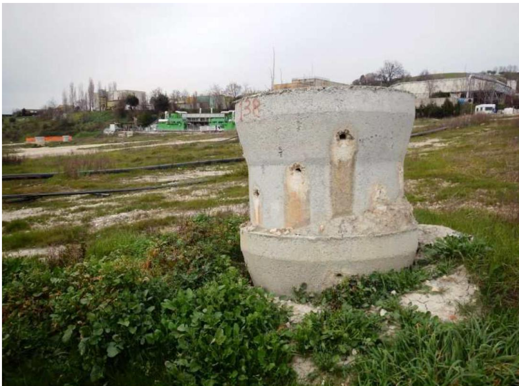
Figura 74: Elementi in cemento pre-forato emergente dalla discarica
