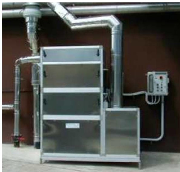
Figura 57: Esempio di Filtro a Zeolite
