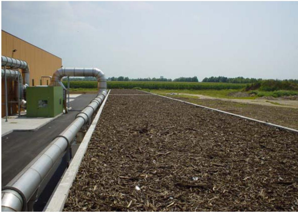
Figura 71: Esempio di biofiltro
