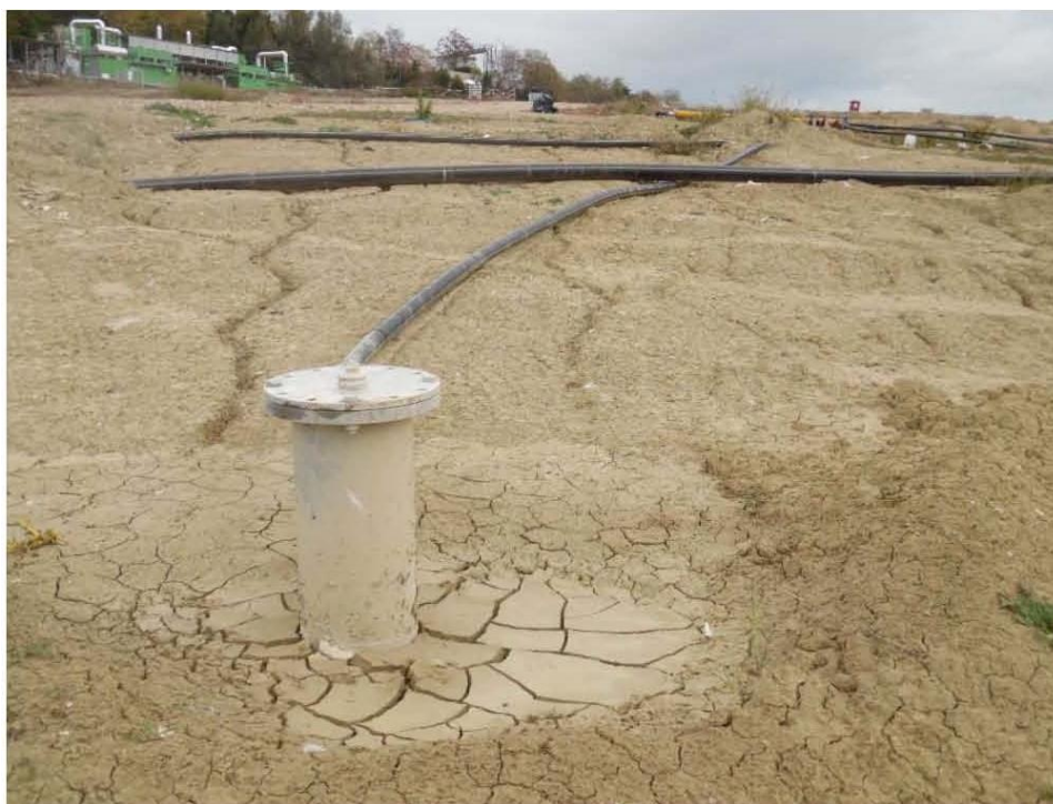
Figura 52: Pozzo biogas
