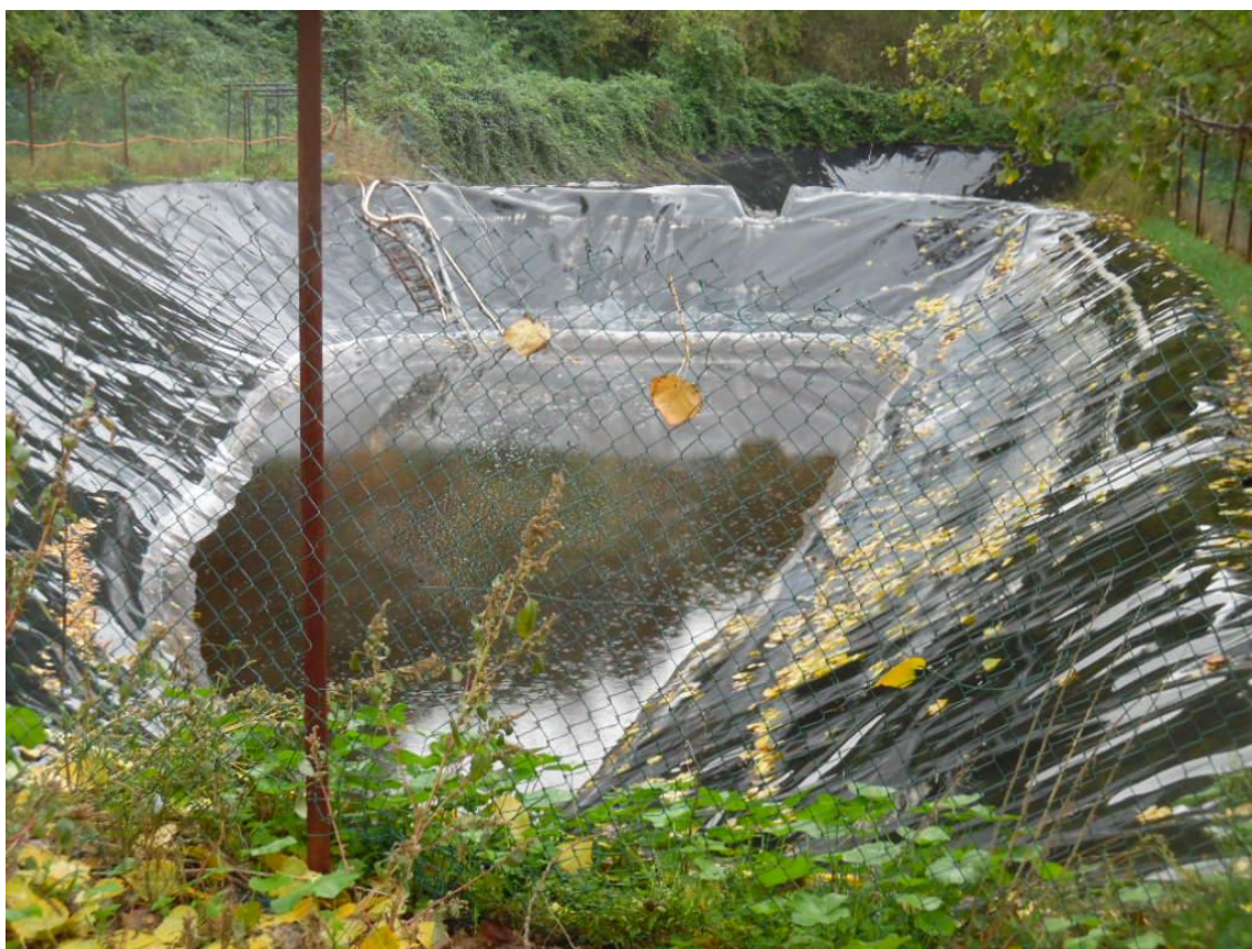
Figura 11: Foto 2-Sistema di stoccaggio percolato con due laghetti
