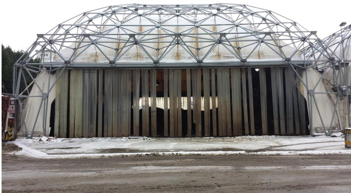
Figura 33: Tensostruttura utilizzata per lo scarico e lo stoccaggio
