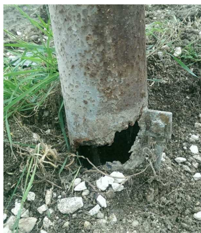
ESEMPI DI SOSTEGNI IN PESSIMO STATO E DA SOSTITUIRE
