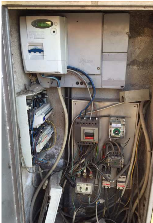
ESEMPIO DI QUADRO NON A NORMA E IN PESSIMO STATO
