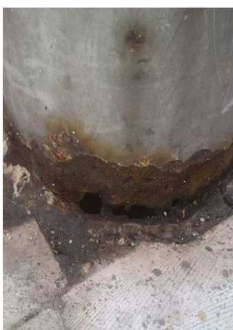
ESEMPI DI SOSTEGNI IN PESSIMO STATO E DA SOSTITUIRE
