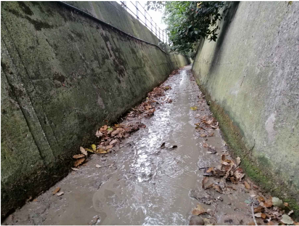
Foto n. 1 - sezione trapezoidale del canale
