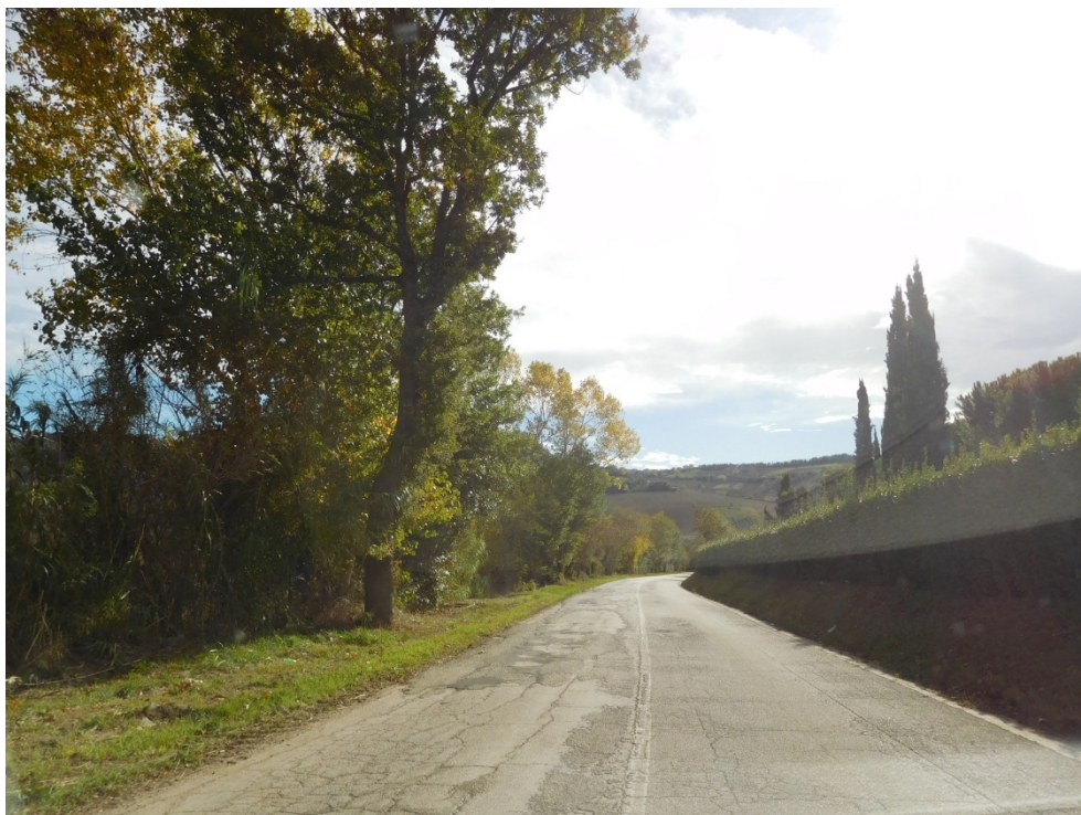
Foto 2 - Fessurazioni longitudinali della pavimentazione stradale ed usura dello strato superficiale.
