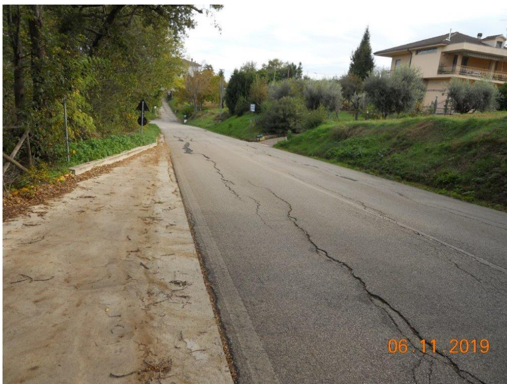
Foto 8 - Fessurazioni longitudinali della pavimentazione stradale ed usura dello strato superficiale.
