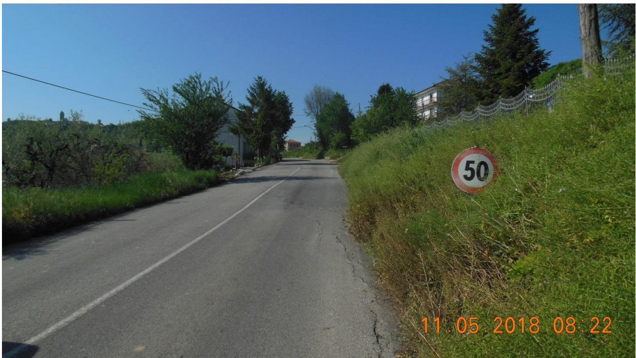
Foto4 - Km 26+120 ca. Avvallamenti del piano viario con fessurazioni longitudinali e trasversali della pavimentazione stradale.
