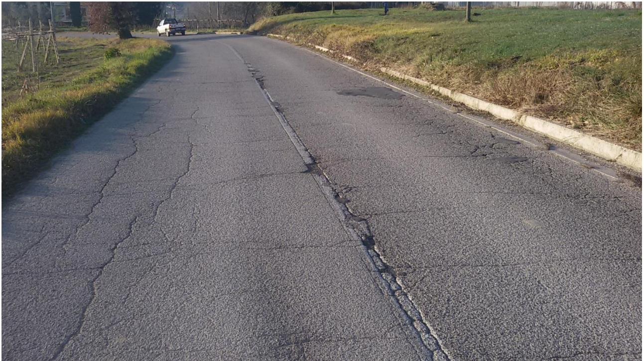
Foto3 - Km 7+300. Avvallamenti del piano viario con fessurazioni longitudinali e trasversali della pavimentazione stradale ed usura dello strato superficiale.
