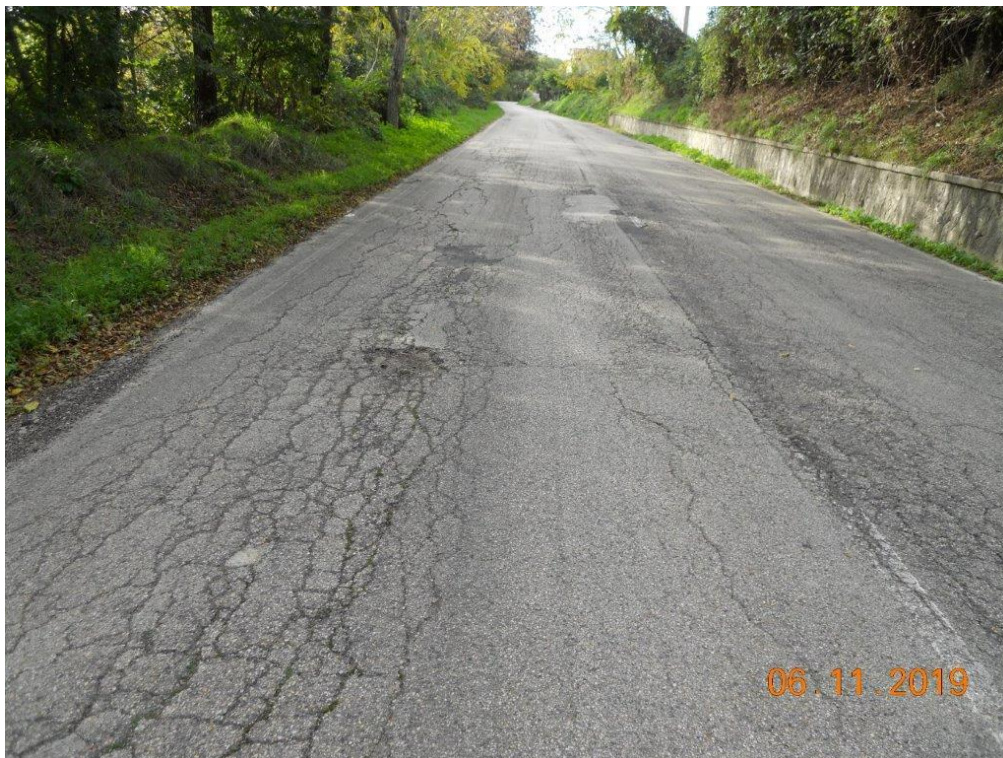
Foto 7 - Fessurazioni longitudinali della pavimentazione stradale ed usura dello strato superficiale.
