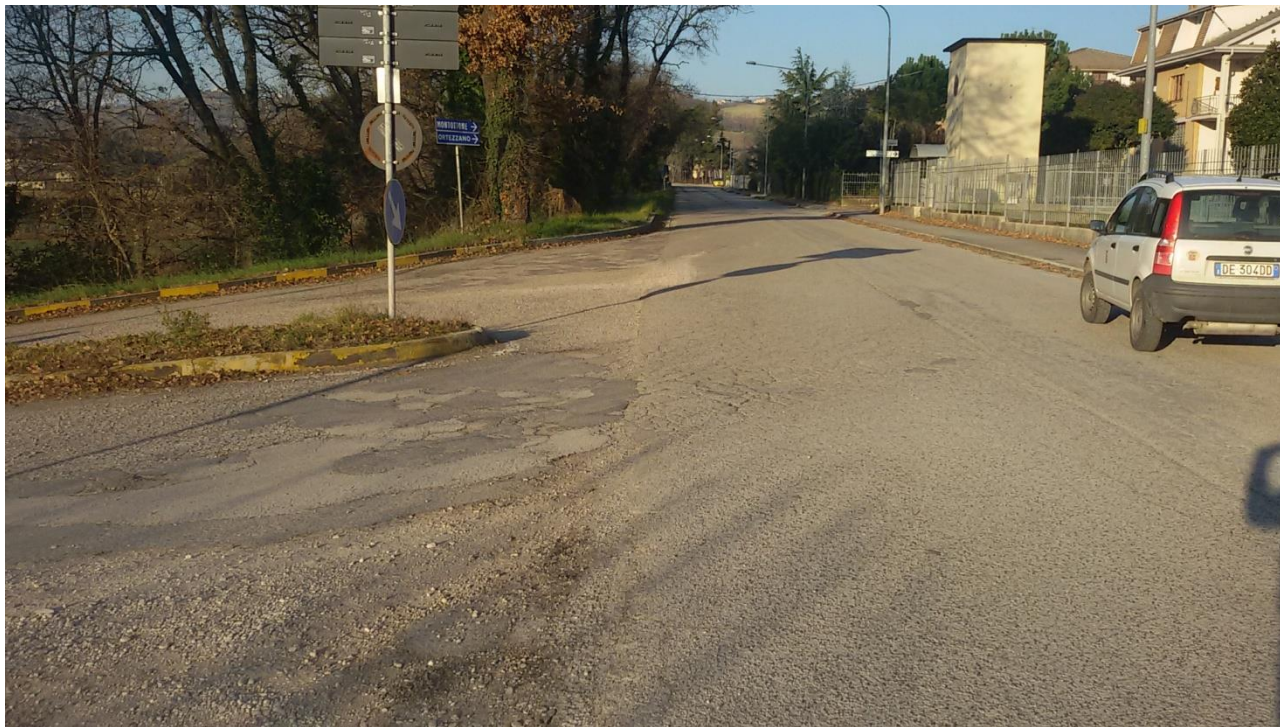
Foto1 - Km 6+600. Fessurazioni longitudinali e trasversali della pavimentazione stradale ed usura dello strato superficiale.
