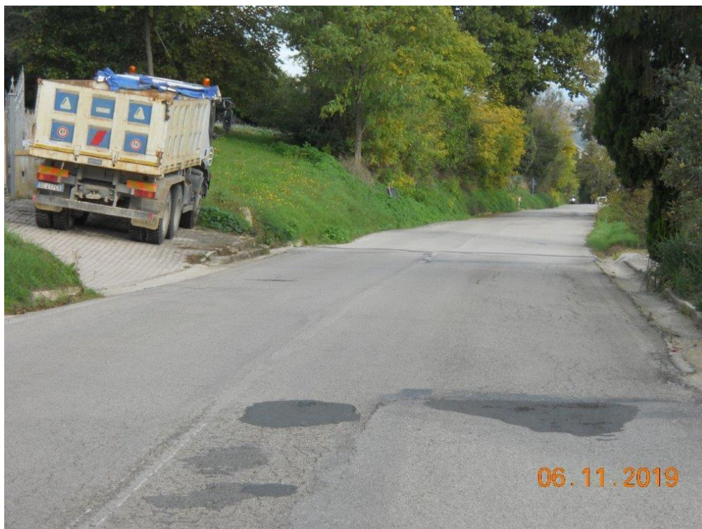
Foto 5 - Avvallamenti del piano viario con fessurazioni trasversali della pavimentazione stradale.
