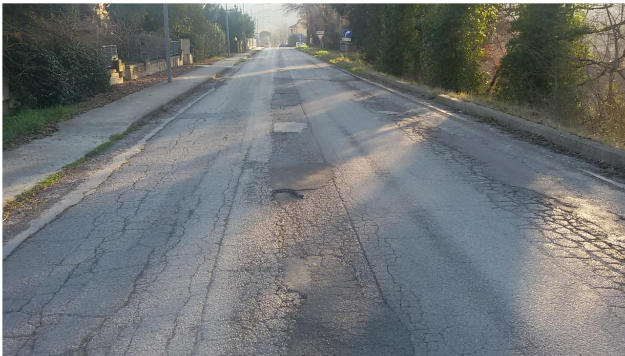
Foto2 - Km 6+750. Avvallamenti del piano viario con fessurazioni longitudinali e trasversali della pavimentazione stradale ed usura dello strato superficiale.
