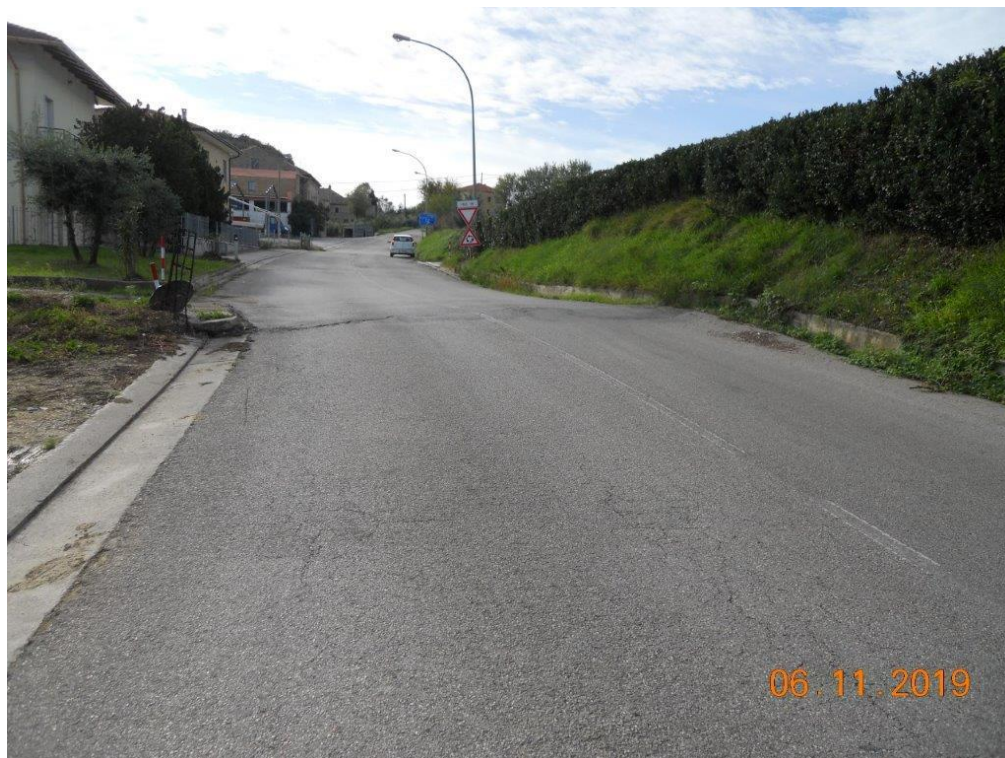
Foto 6 - Avvallamenti del piano viario con fessurazioni trasversali della pavimentazione stradale.
