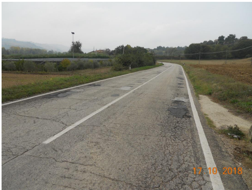
Foto 2 - Evidente fessurazione diffusa del bordo della strada ed un avanzato livello di usura.
