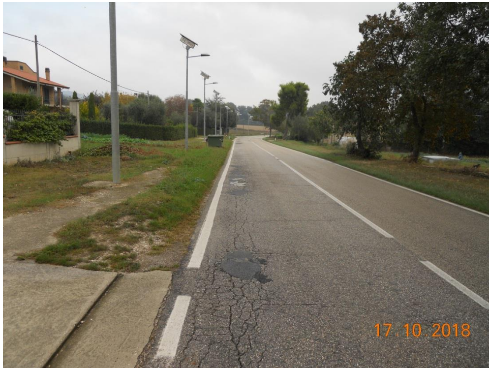
Foto 1 - Fessurazione diffusa del bordo della strada ed un avanzato livello di usura.
