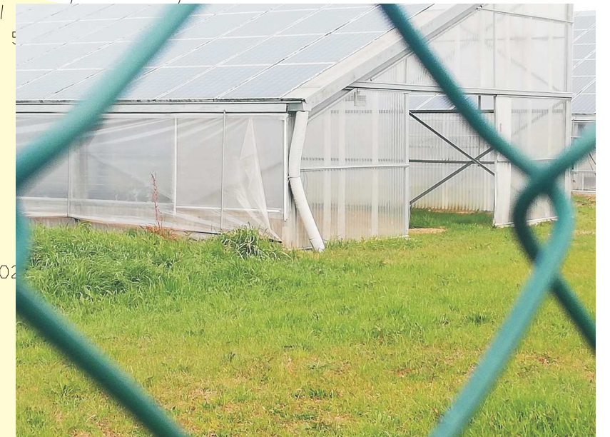
Foto 4: sistema di raccolta e convogliamento nel sottosuolo delle acque di gronda delle serre esistenti
