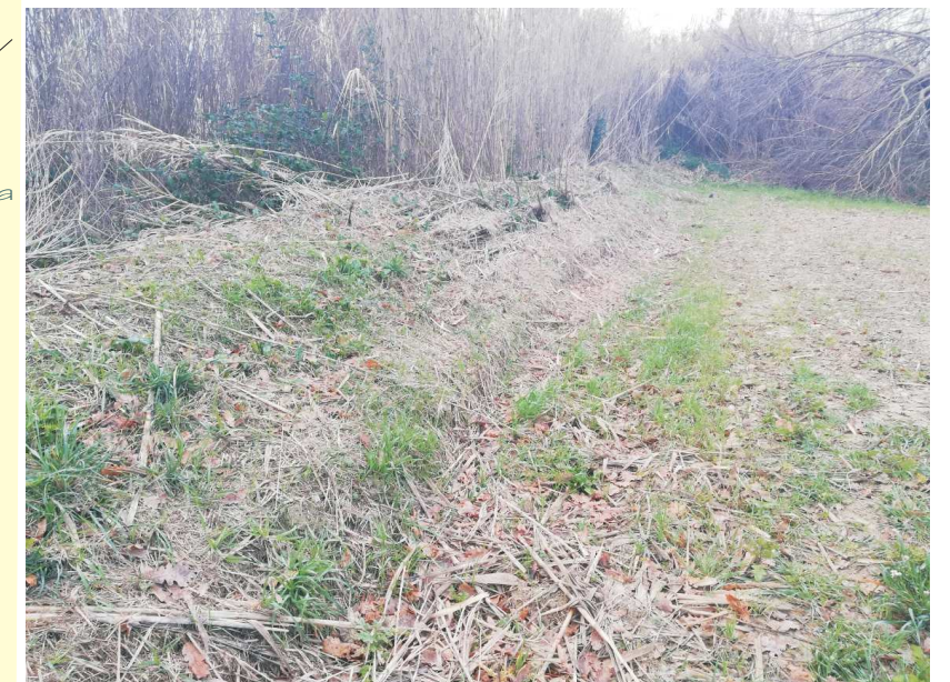
Foto 3: argine in terra alto circa 70 cm del fosso di scolo posto lungo il limite proprietà orientale
