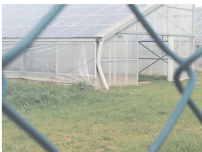
Foto 6: sistema di raccolta e allontanamento in sotterraneo delle acque di gronda delle serre esistenti
