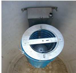
Mod.FC-OG-20 Filtro a coalescenza e otturatore a galleggiante incorporato
