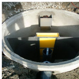
Particolare di una vasca disoleatore con carter di calma in entrata Filtro a coalescenza e otturatore a galleggiante separato in uscita
