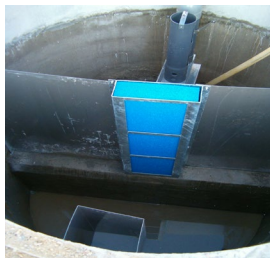
Particolare di una vasca disoleatore con carter di calma in entrata Filtro a coalescenza e otturatore a galleggiante separato in uscita
