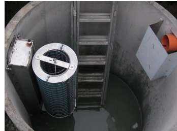
Mod.FC-OG-20 Filtro a coalescenza e otturatore a galleggiante incorporato
